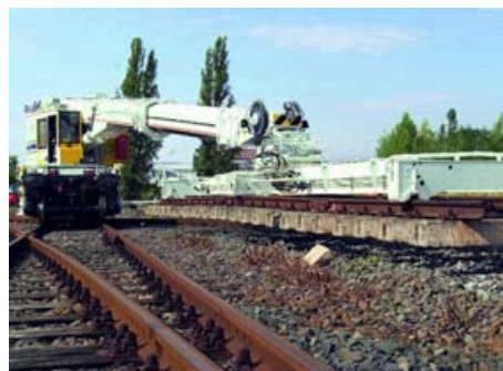
Odcinki torowiska mogą być przemieszczane za pomocą hydraulicznego wysięgnika
