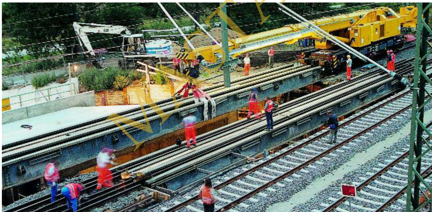
Multi Tasker 1200 przy podnoszeniu elementów dużego mostu zewnętrznego dla DB AG
