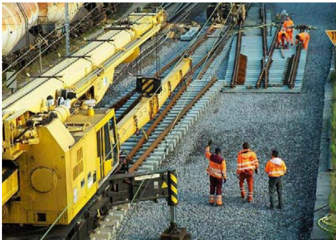
↑ Zwrotnica podwieszona pod wysięgnikiem
