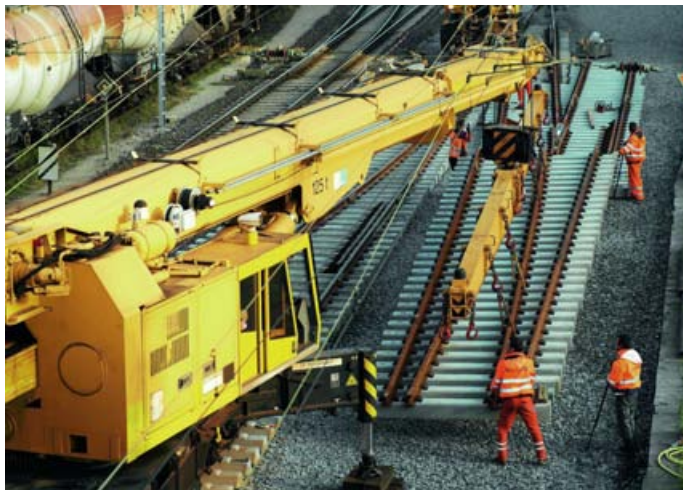
↑ Zwrotnica układana na miejscu montażu
