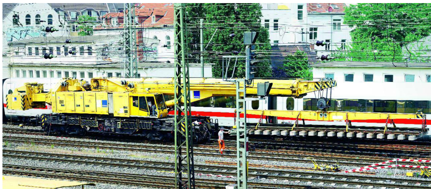
↑ W czasie pracy żurawia odbywa się normalny ruch kolejowy.
