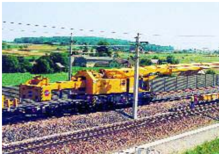
↑ Układanie odcinków torowiska przy ograniczonej przestrzeni
