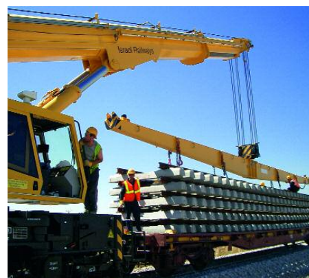
Odcinki torów z podkładami są układane w całości, bezpośrednio na miejsce montażu
