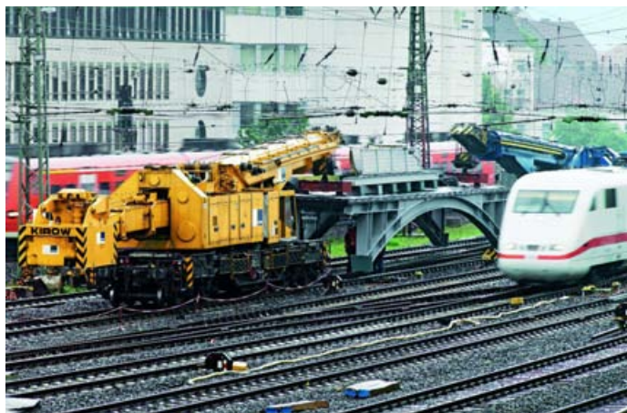
Prace mostowe wykonywane w tandemie żurawi
